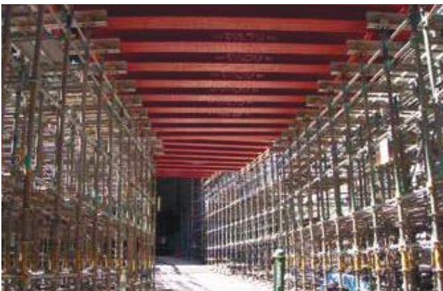
車路確保(H型鋼使用)
