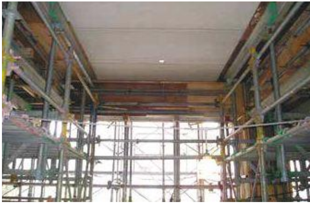
PCスラブ設置状況
