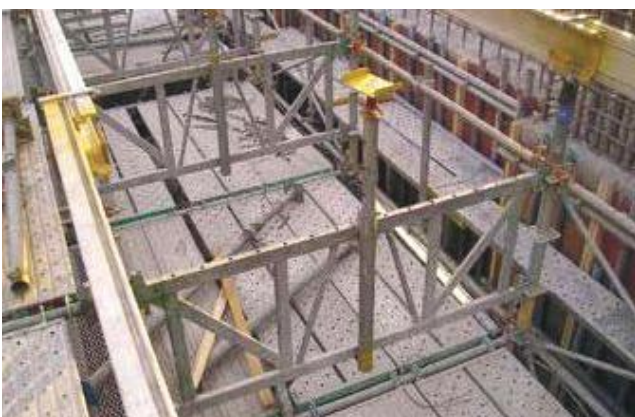
自在梁下枠+自在梁下枠サポート
