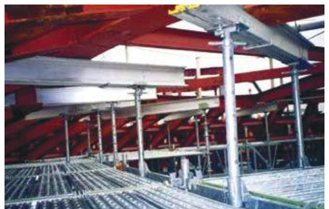
鉄骨受け状況
