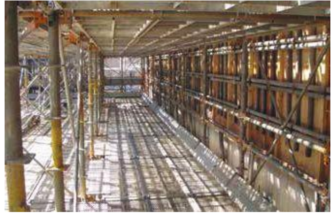
作業通路(壁側)
