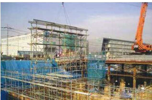
吊り込み状況
