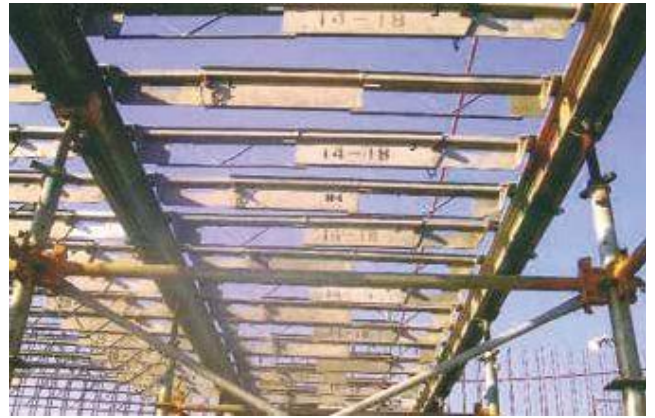
ビーム設置状況
