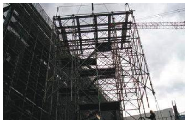
吊り込み状況
