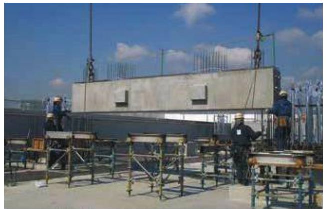
PC梁設置状況
