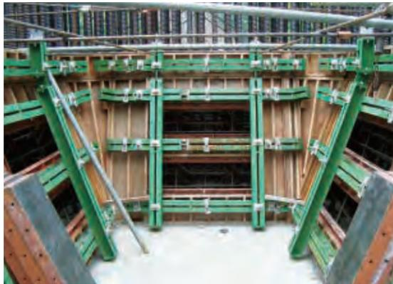
中空型枠 内ハンチ 窓型枠
