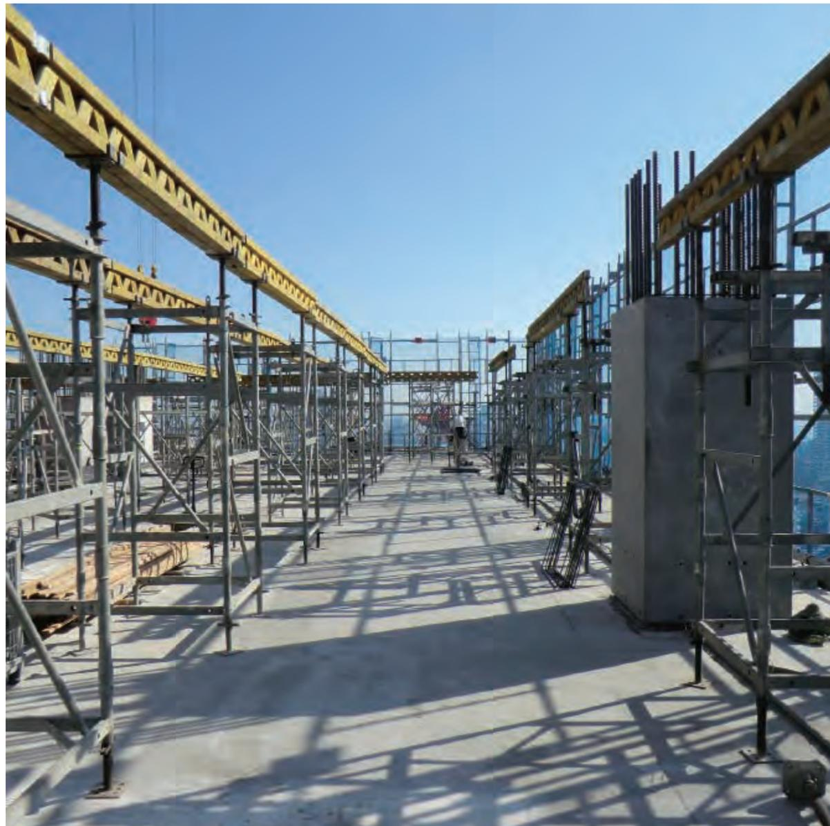
STシステムは新しいタイプの支保工です。スタッキングフレームという軽量コンパクト(高さ50cm、重さ7kg)な部材をカップに差し込み重ねるだけの単純組立て、はじめての方でも簡単に組み立てることができます。
