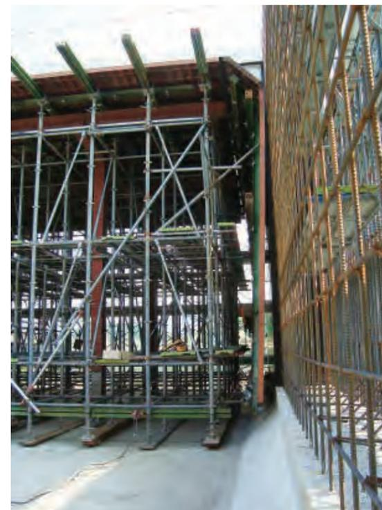
移動台車 支保工+型枠(スラブ側面)
