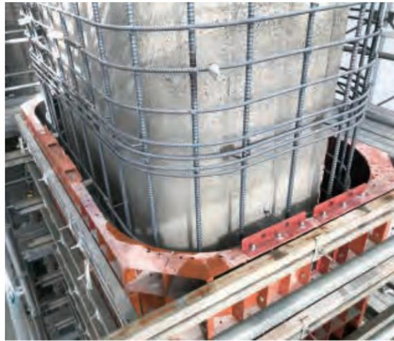
型枠設置完了全景
