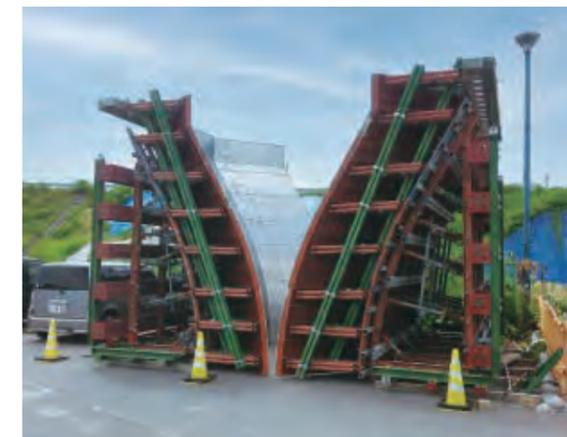
水平カット梁底型枠
