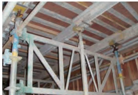
自在梁下枠 + 自在梁下枠サポートS
