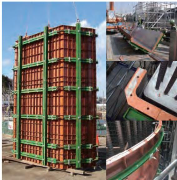
リブ厚72mmだから、木製型枠との併用が可能。
