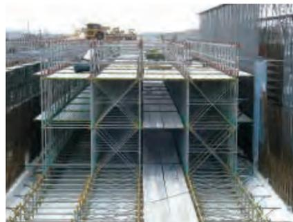
建築現場の大空間や、土木現場の水処理場・BOXカルバート・鉄道橋等の現場に適したシステム支保工です。
