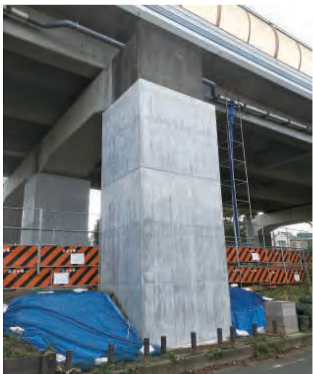
出来映え(メタルフォーム 幅300サイズ施工時)
