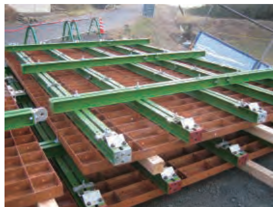
木製型枠との併用例 ドレン部分
