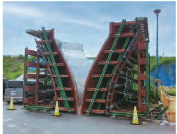
水平カット梁底型枠
