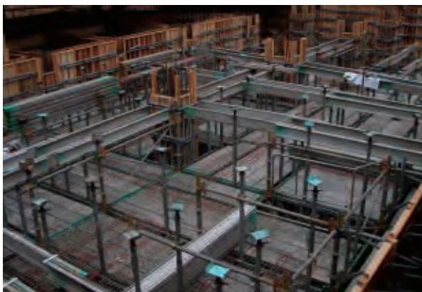
全景（自在梁下枠サポート設置時）
