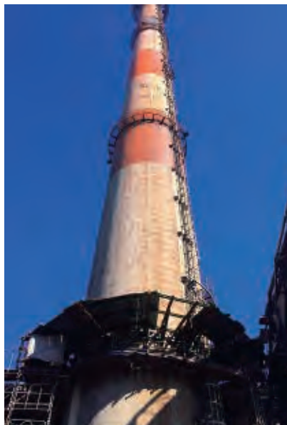
煙突解体工事
