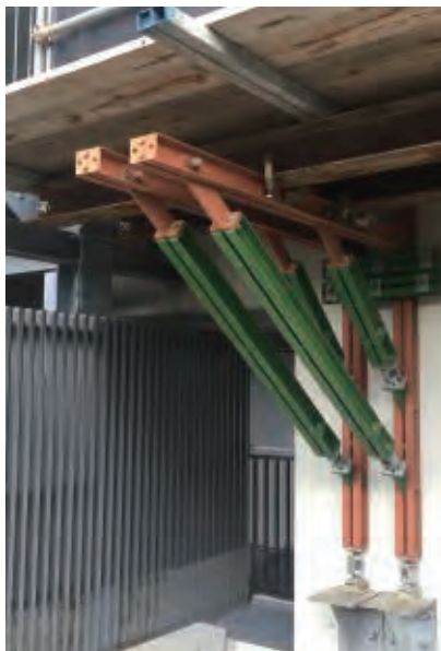
マンション改修工事
