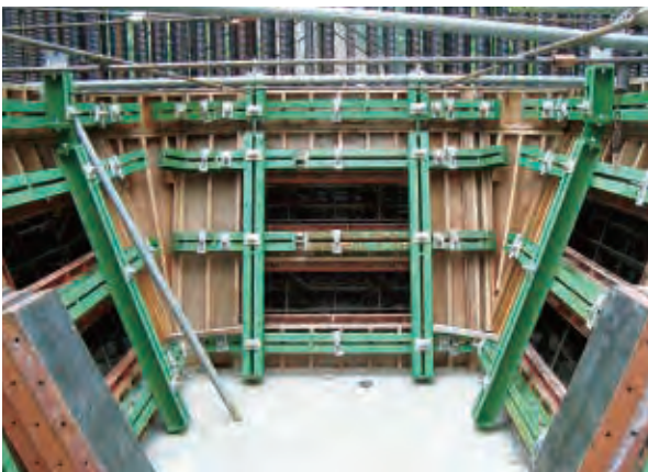
中空型枠 内ハンチ 窓型枠
