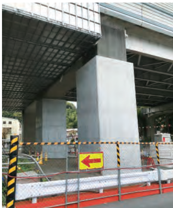
出来映え(ステンメタル72 幅600サイズ施工時)
