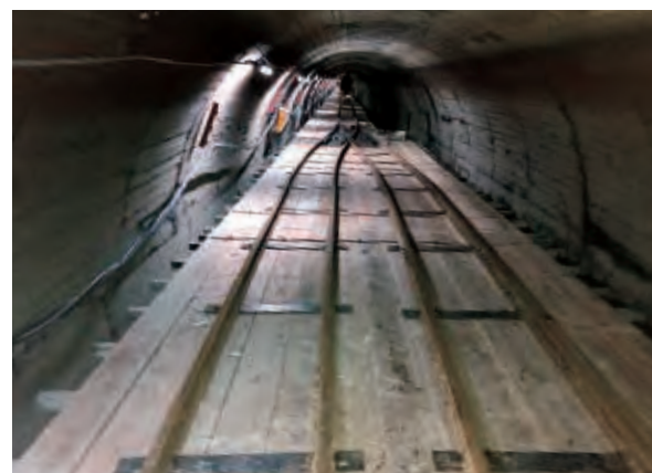
水路トンネル補修工事
