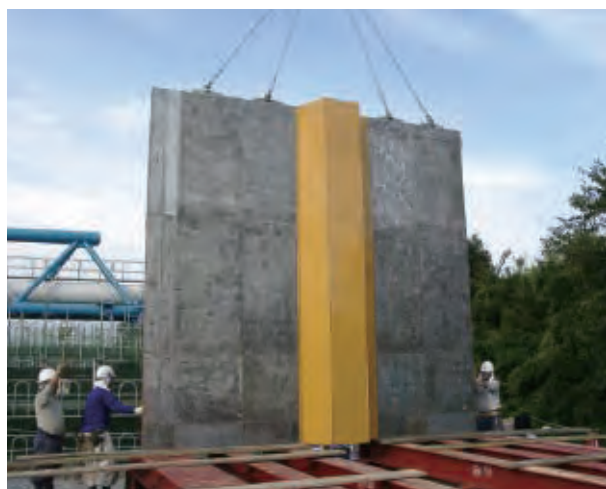
木製型枠との併用例 ドレン部分
