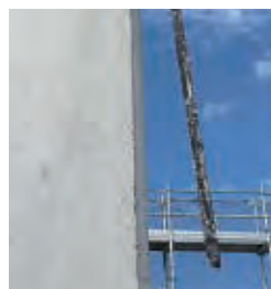
木製型枠+面木 脱型直後
