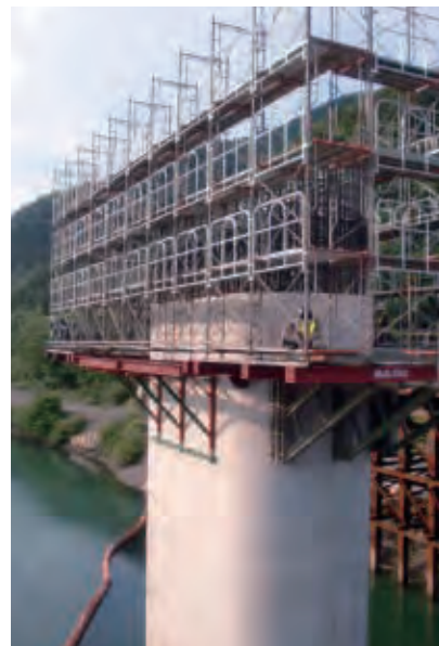
下部工新設工事
