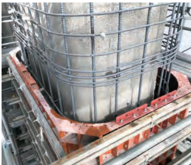
型枠設置完了全景
