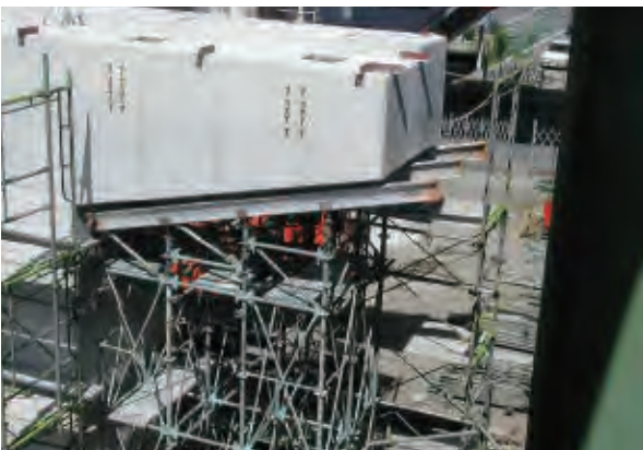
下部工施工状況
