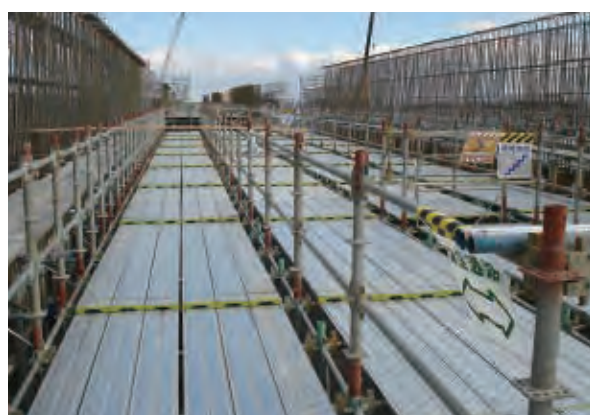
最上段ステーキング（鋼製足場板）
