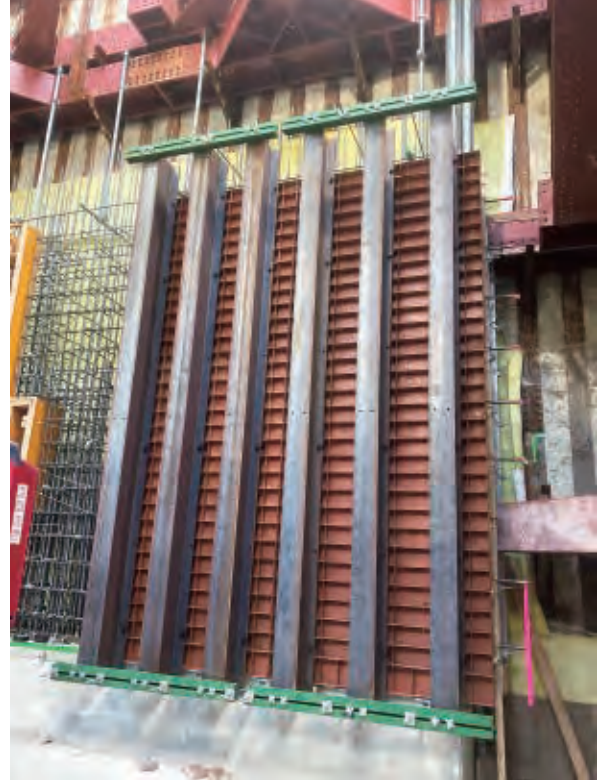
ノンセバ型枠 H鋼
