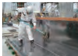
清掃+剥離剤塗布
