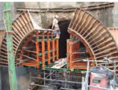
トンネル部分
