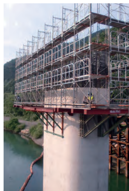
下部工新設工事
