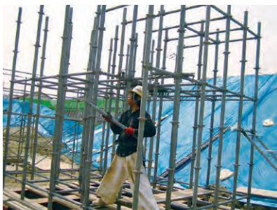
くさび式支保工組立状況
