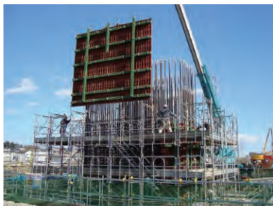
建て込みの状況（建て込みの目安は約30～50㎡/人）
