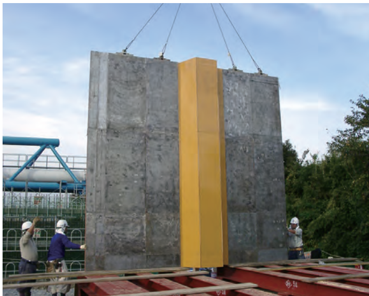
木製型枠との併用例 ドレン部分
