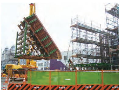
自在トラス吊り上げ状況
