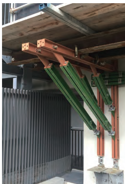
マンション改修工事
