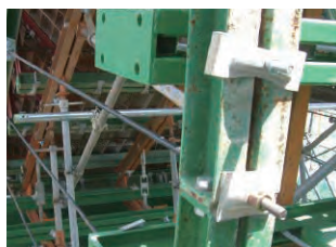
OBトラスから締め込んだ部分
