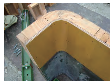
木製型枠との併用例 内部面
