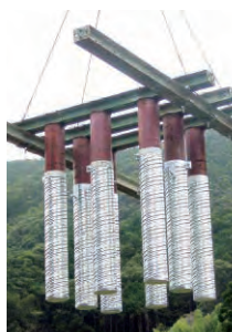
吊り上げ状況
