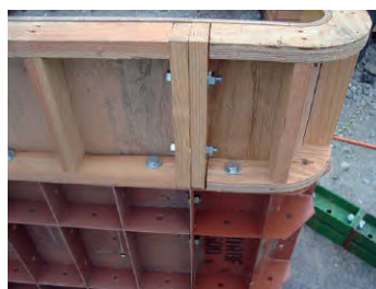
木製型枠との併用例 外部面
