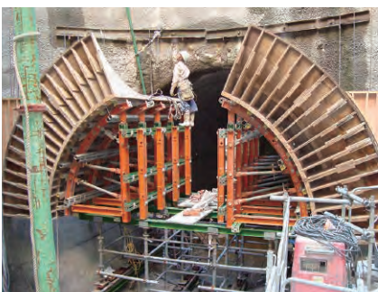
トンネル部分
