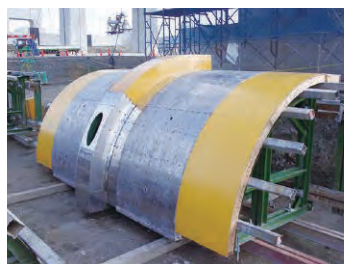
木製型枠との併用例 円形
