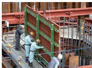
建て込み状況
