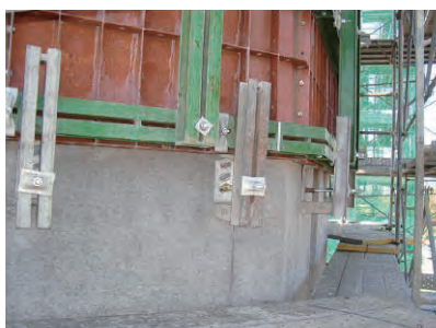
2ロット以降で型枠下部を支えるアングルブラケット
