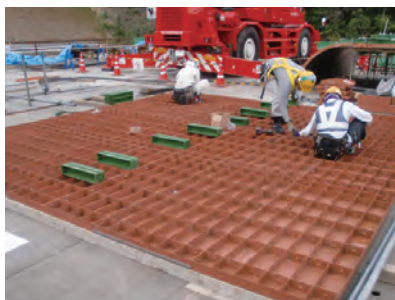
地組みの状況（地組みの目安は約10～15㎡/人）
