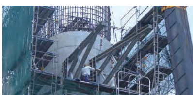
ASブラケット取付状況
