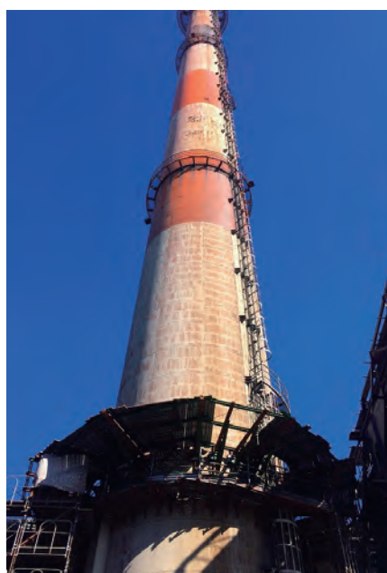
煙突解体工事
