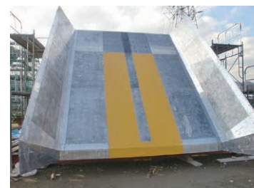
木製型枠との併用例 梁底
